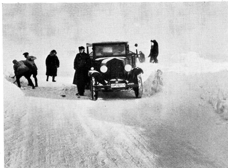
Abb. 9. Fahrbahnen vollkommen verweht. Abfahren der eingewehten Schneemassen mit Lastkraftwagen aus Einschnitten
