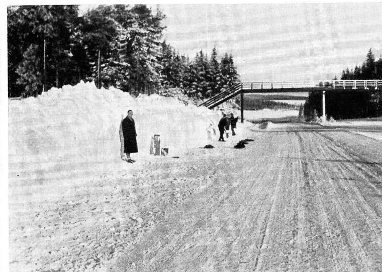
Abb. 8. Unvollkommene Beseitigung des Schnees von der Fahrbahn mittels Schneepflug und ergänzendes Freischaufeln von Hand an verwehten Stellen
