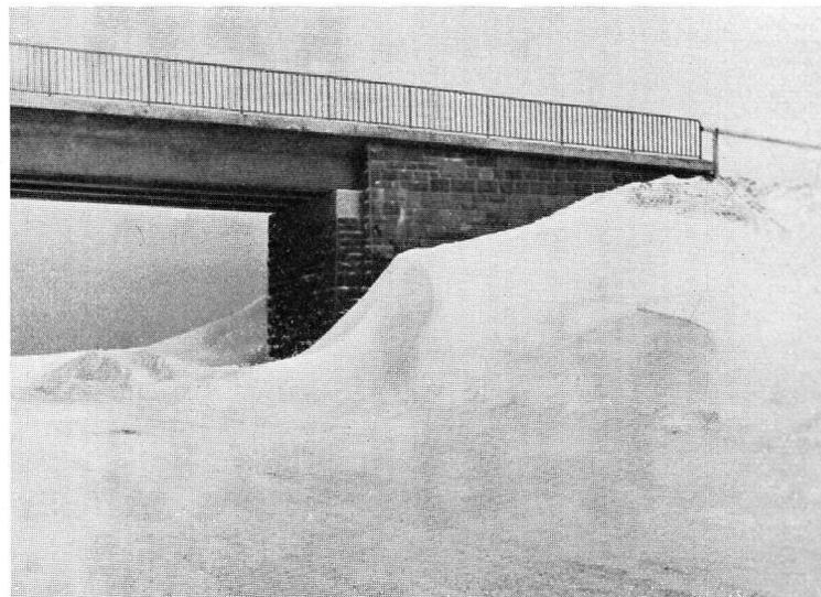
Abb. 4. Verwehung der Fahrbahn, veranlaßt durch ein Brückenwiderlager
