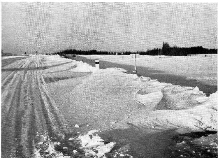
Abb. 2. Verwehung der Fahrbahn, ausgehend vom Räumgut der Schneepflüge
