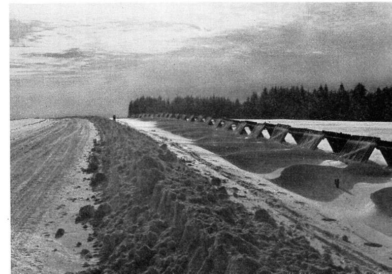
Abb. 15. Wirkung eines Schneeschutzaunes der Autobahn
