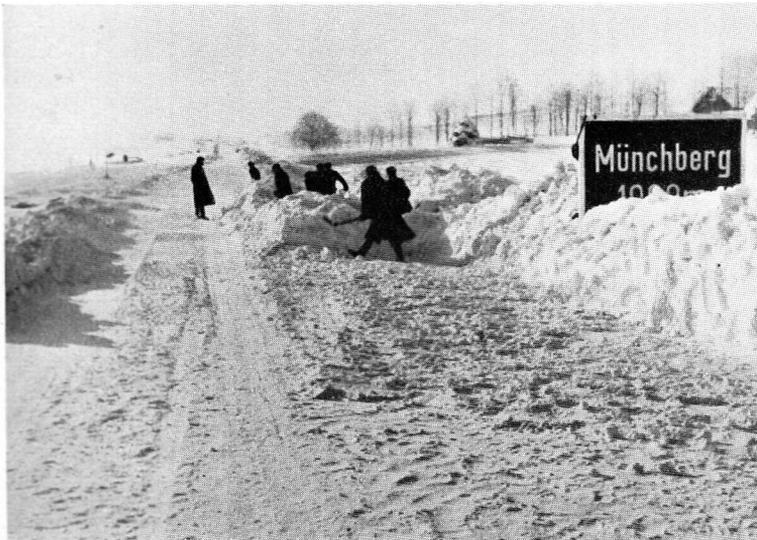
Abb. 11. Freimachen der vollkommen zugewehrten Fahrbahn im Handbetrieb
